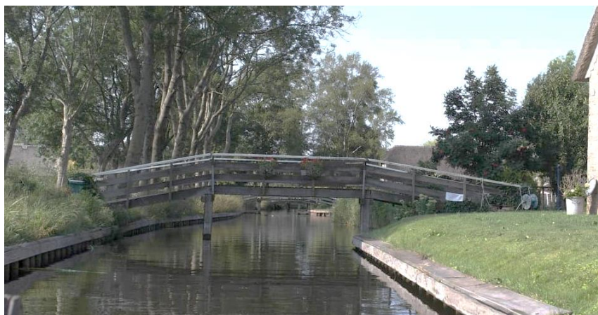
Rysunek 51 Przykład kładki nad rzeką i skarp [fot. Elzbieta Marczak]
