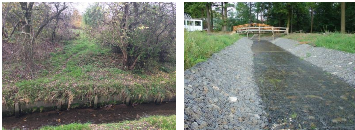
Rysunek 54 Przykładowe umocnienie skarpy koszami gabionowymi 21
